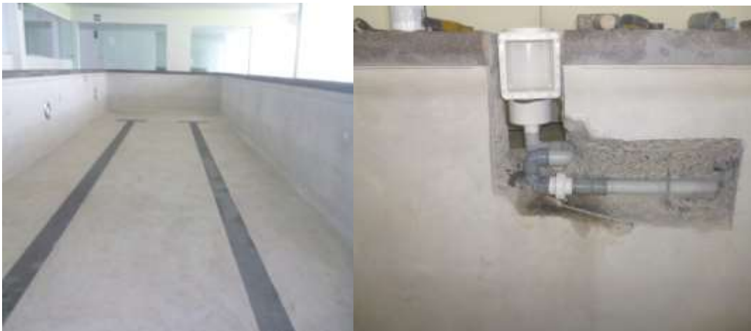
Piscina en lima peru Rehabilitada por Disambiental
